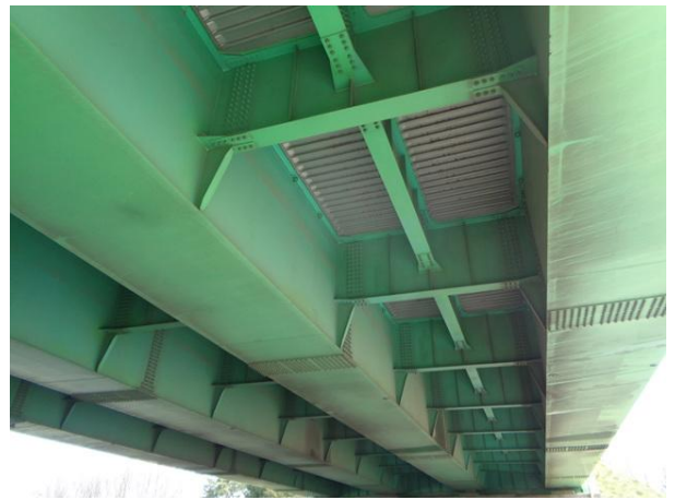
바닥판, 거더외부 전경
